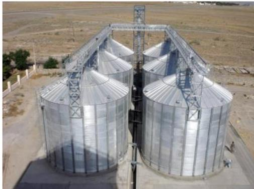
9. **Silos de base cônica**, de chapas onduladas de aço galvanizado, utilizados para armazenar grãos, cujo cone pode ter um ângulo de 45 a 65°, compreendendo um sistema de controle de temperatura interior que detecta zonas de temperatura elevada, bem como a presença de insetos. O arejamento dos produtos armazenados é assegurado por ventiladores radiais e axiais.
